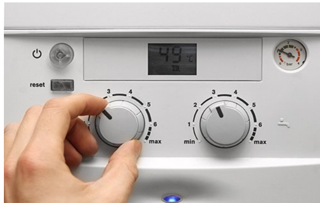
Ilustración 32: Panel frontal de caldera de gas (Fuente: propia)
