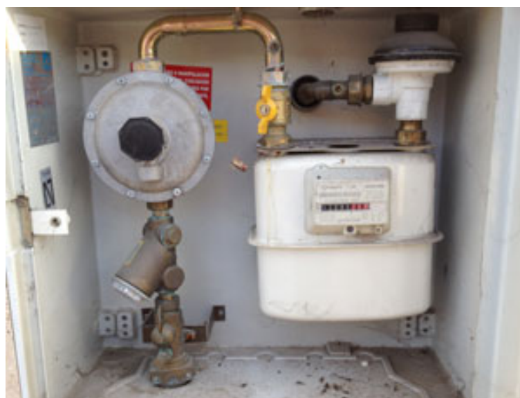
Ilustración 30: Regulador de gas, válvula de usuario y contador. (Fuente: propia)
