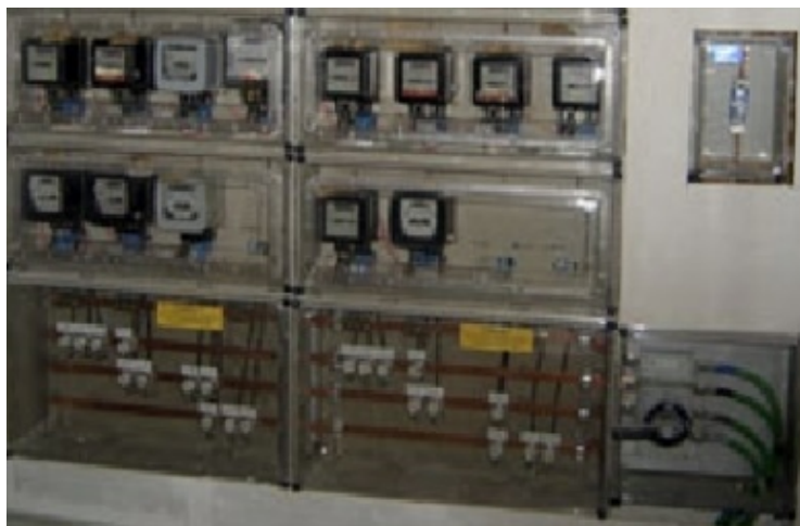
Ilustración 9: Esquema y cuadro centralizado de contadores
