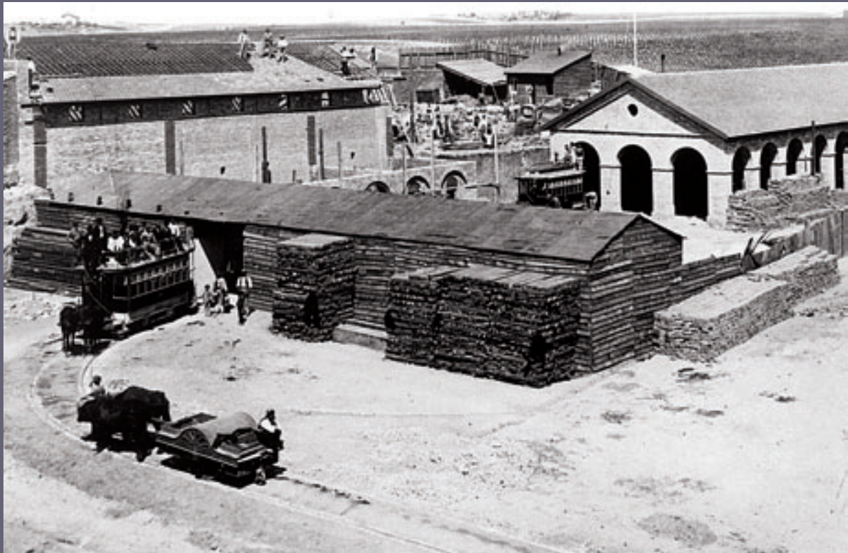
Estación (cocheras) de Salamanca en construcción (1870). Se ubicaban en la calle Serrano esquina con la calle Maldonado, lo que entonces era el límite de Madrid, donde hoy se encuentra la Parroquia de San Francisco de Borja.
