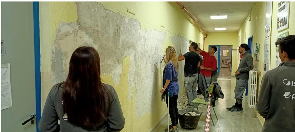
*Figura 4. Nodo 14. Raspado del gotelé y pintura existentes por parte del alumnado del CFGM de Obras de Interior, Decoración y Rehabilitación. Imagen: Taller de Arquitectura Educativa.*
