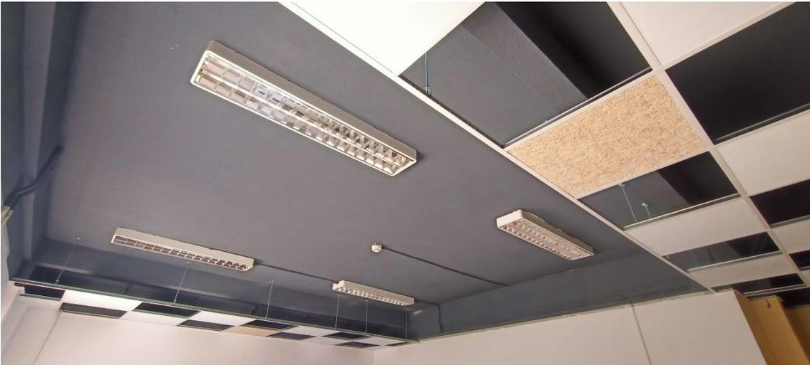
Figura 17. Nodo 14. Espacio cooperativo de EOC. Dos secciones de falso techo suspendido ya colocadas
