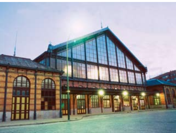
Fachada actual de la estación.
