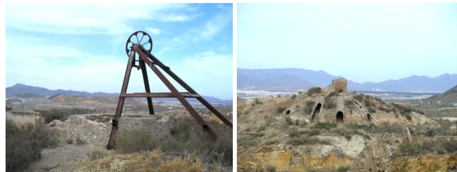
Arriba: San Cristóbal-Perules , castillete de acceso a un antiguo pozo minero y chimeneas inclinadas. Abajo, sector de Pedreras Viejas , acceso a un pozo e instalaciones minero-metalúrgicas abandonadas.
