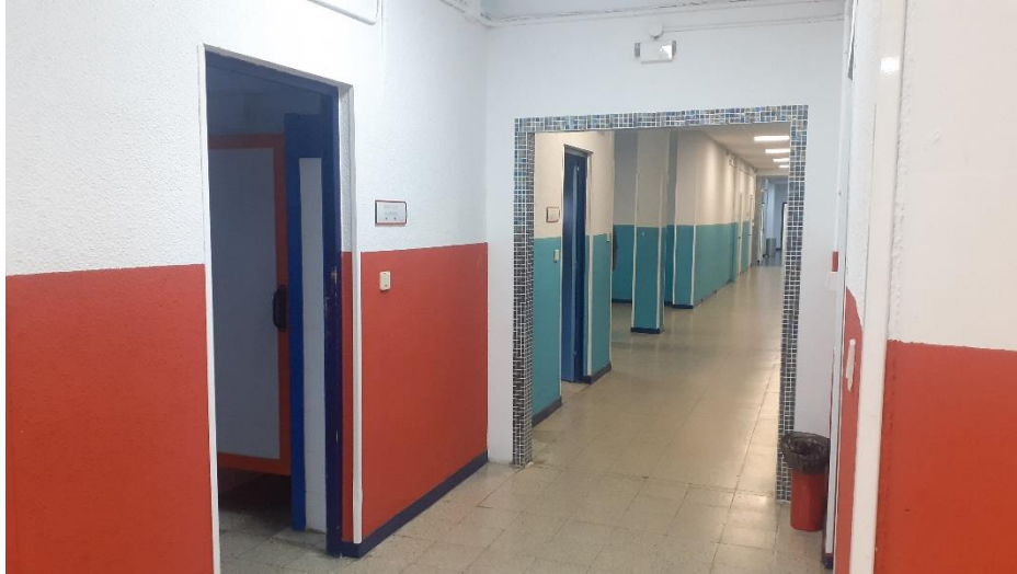
Figura 2. Acceso a los baños de alumnado
